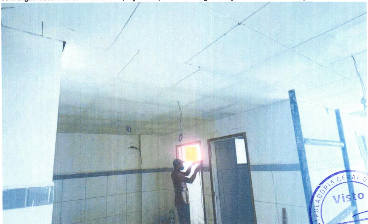
FOTO 04 - Revestimento cerâmico para parede, 10 x 10 cm, Eliane, linha galeria branco mesh, pei - 3, aplicado com argamassa industrializada ac-ii, rejuntado, exclusive regularização de base ou emboço - Rev 01
