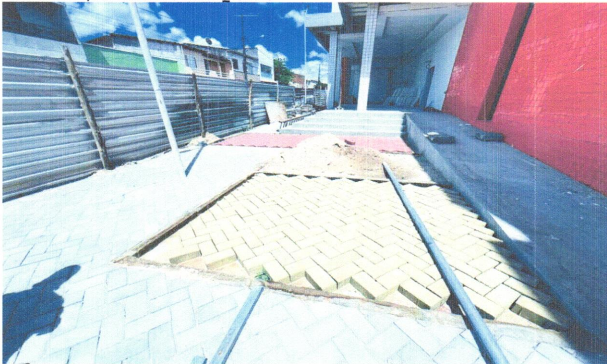
FOTO 44 - EXECUÇÃO DE PASSEIO EM PISO INTERTRAVADO, COM BLOCO RETANGULAR COLORIDO DE 20 X 10 CM, ESPESSURA 6 CM. AF_12/2015
