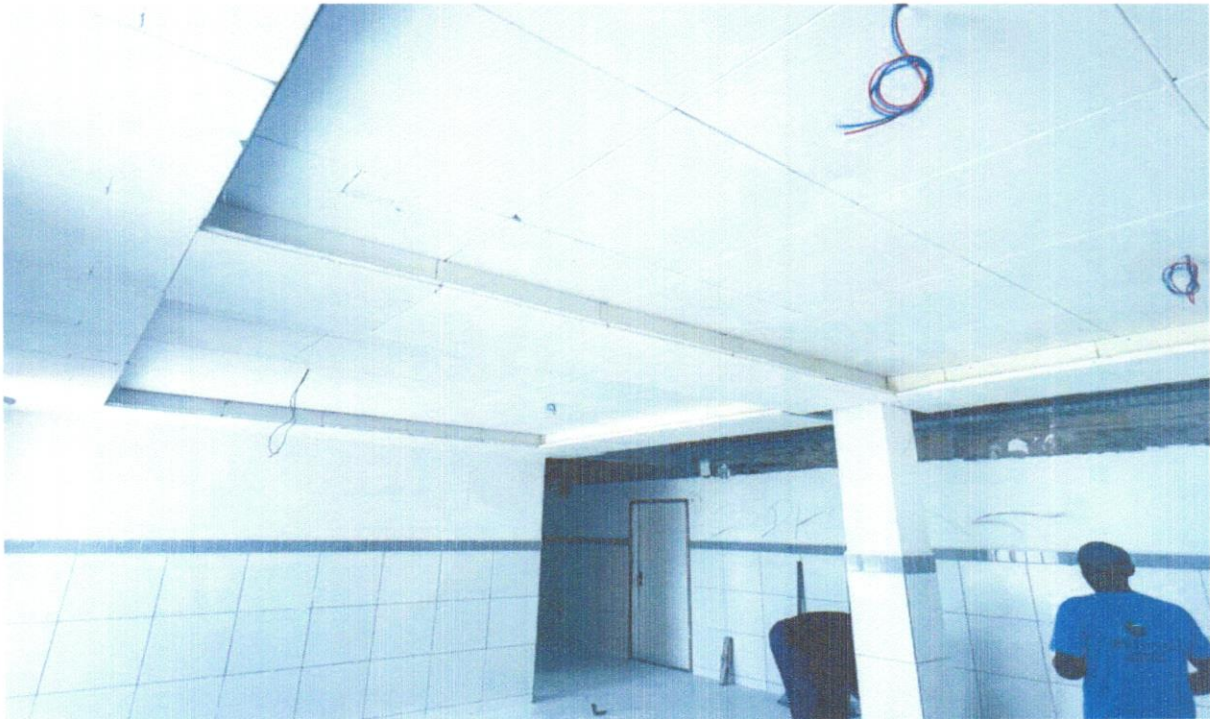
FOTO 18 - ACABAMENTOS PARA FORRO (MOLDURA DE GESSO). AF_05/2017
