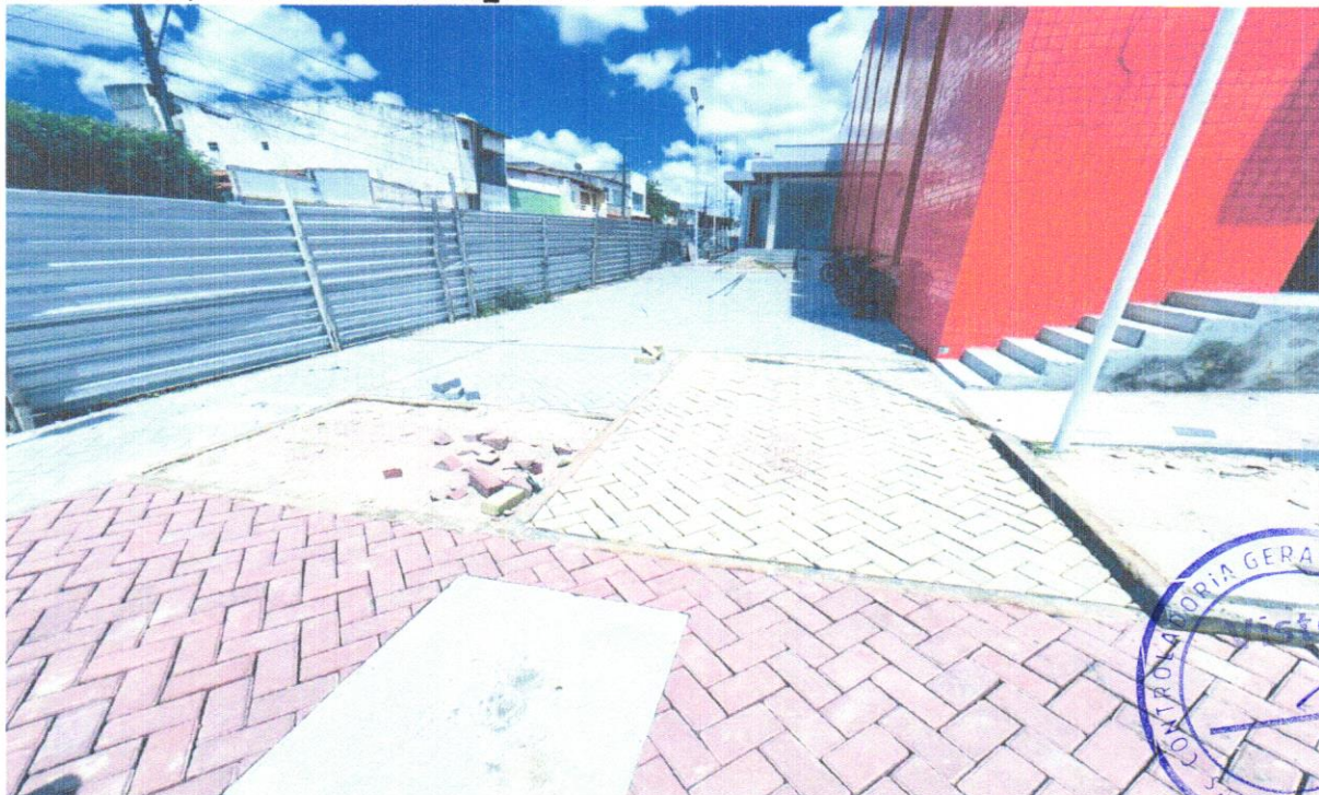
FOTO 44 - EXECUÇÃO DE PASSEIO EM PISO INTERTRAVADO, COM BLOCO RETANGULAR COLORIDO DE 20 X 10 CM, ESPESSURA 6 CM. AF_12/2015
