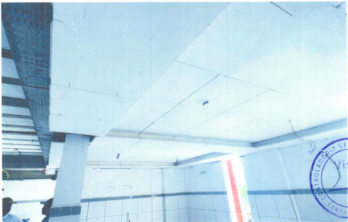
FOTO 18 - ACABAMENTOS PARA FORRO (MOLDURA DE GESSO). AF_05/2017
