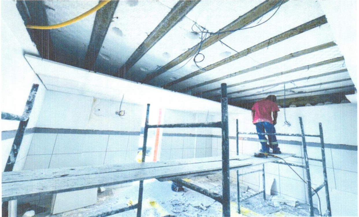
FOTO 20- FORRO EM PLACAS DE GESSO, PARA AMBIENTES COMERCIAIS. AF_05/2017_P
