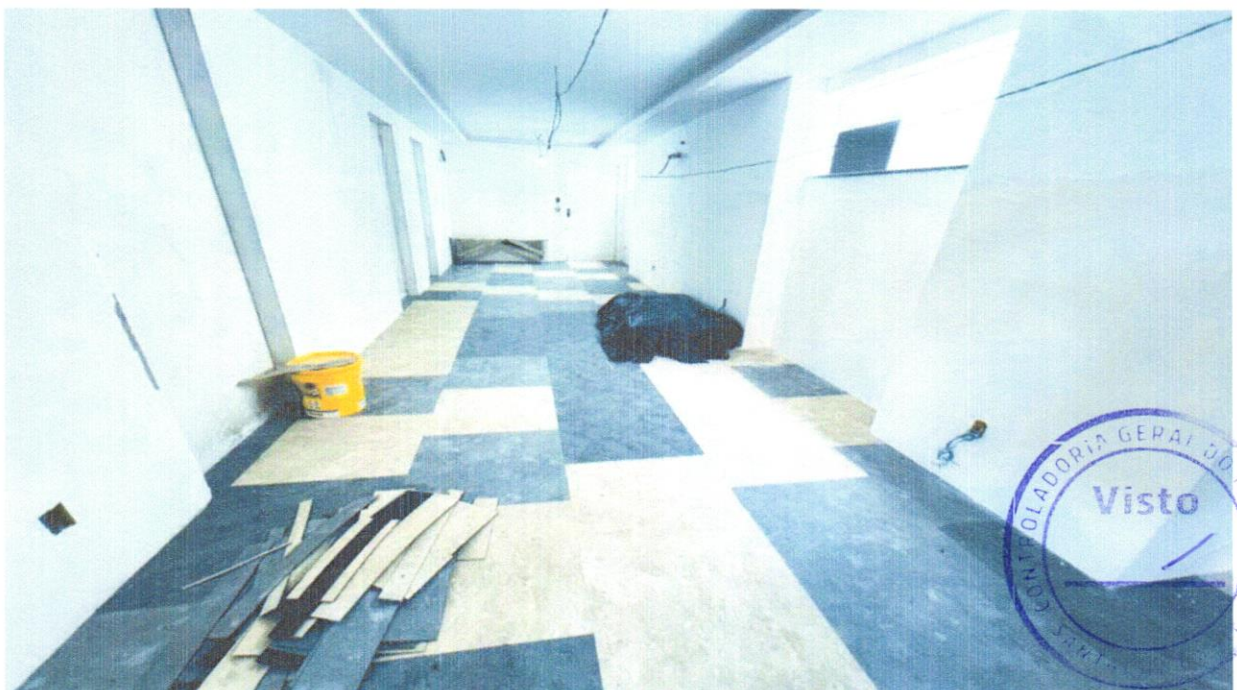
FOTO 26 - EMASSAMENTO COM MASSA A OLEO, DUAS DEMAOIS
