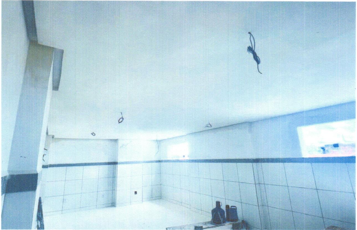
FOTO 26 - EMASSAMENTO COM MASSA A OLEO, DUAS DEMAOIS
