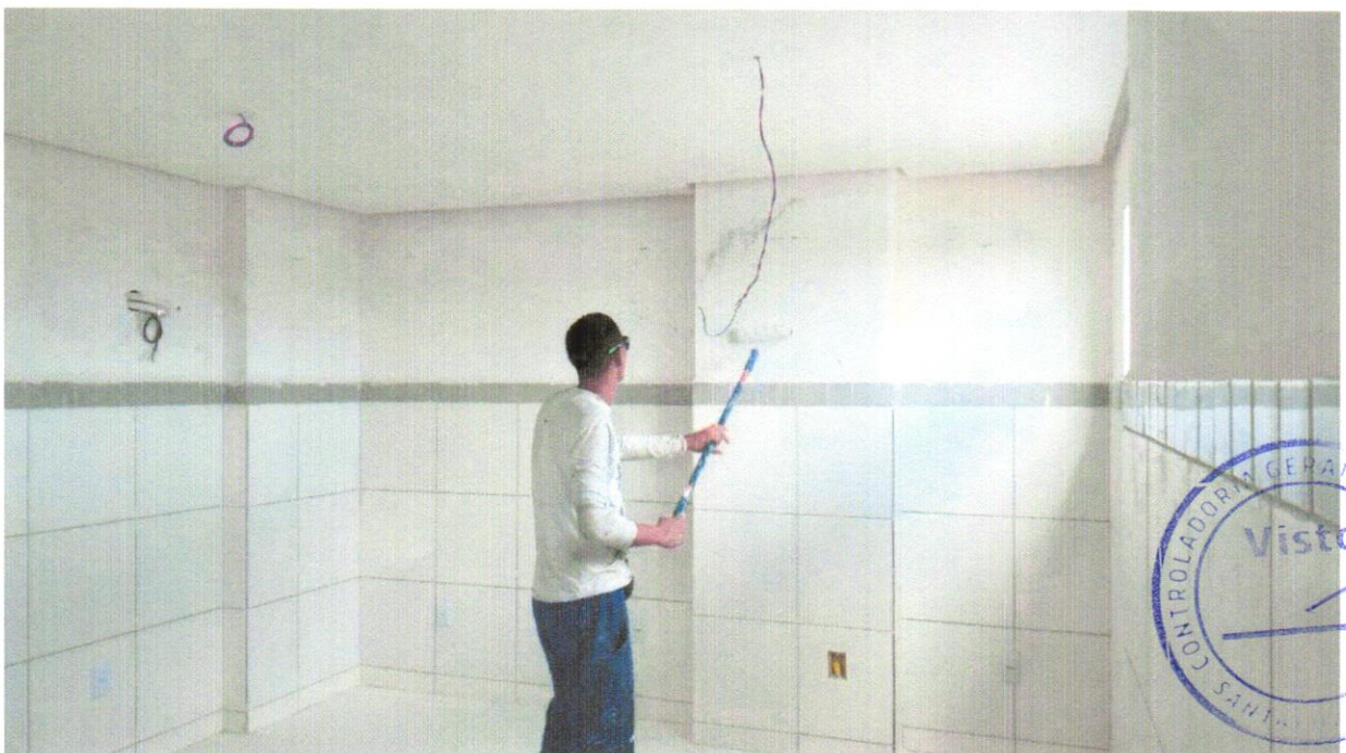
FOTO 28 - APLICAÇÃO MANUAL DE PINTURA COM TINTA LÁTEX ACRÍLICA EM TETO, DUAS DEMÃOS. AF_06/2014
