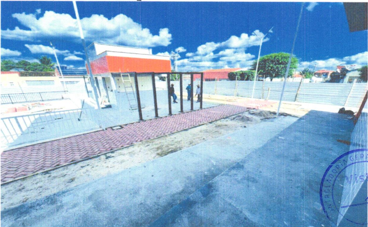
FOTO 46 - EXECUÇÃO DE PASSEIO EM PISO INTERTRAVADO, COM BLOCO RETANGULAR COLORIDO DE 20 X 10 CM, ESPESSURA 6 CM. AF_12/2015
