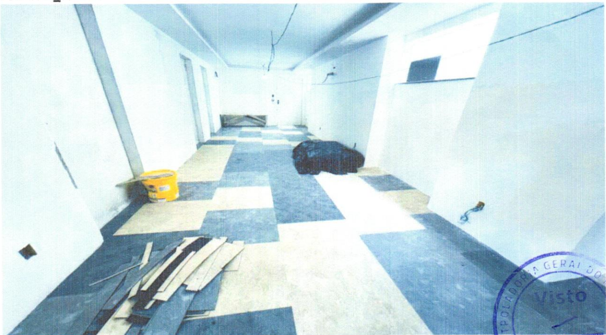
FOTO 10 - PISO VINÍLICO SEMI-FLEXÍVEL EM PLACAS, PADRÃO LISO, ESPESSURA 3,2 MM, FIXADO COM COLA. AF_09/2020
