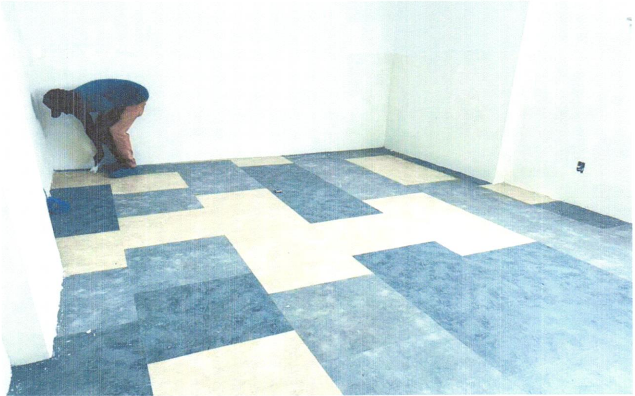
FOTO 10 - PISO VINÍLICO SEMI-FLEXÍVEL EM PLACAS, PADRÃO LISO, ESPESSURA 3,2 MM, FIXADO COM COLA. AF_09/2020
