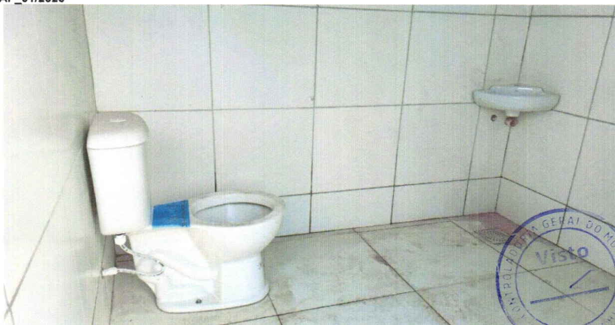
FOTO 34 - VASO SANITÁRIO SIFONADO COM CAIXA ACOPLADA LOUÇA BRANCA - PADRÃO MÉDIO, INCLUSO ENGATE FLEXÍVEL EM METAL CROMADO, 1/2 X 40CM - FORNECIMENTO E INSTALAÇÃO. AF_01/2020
