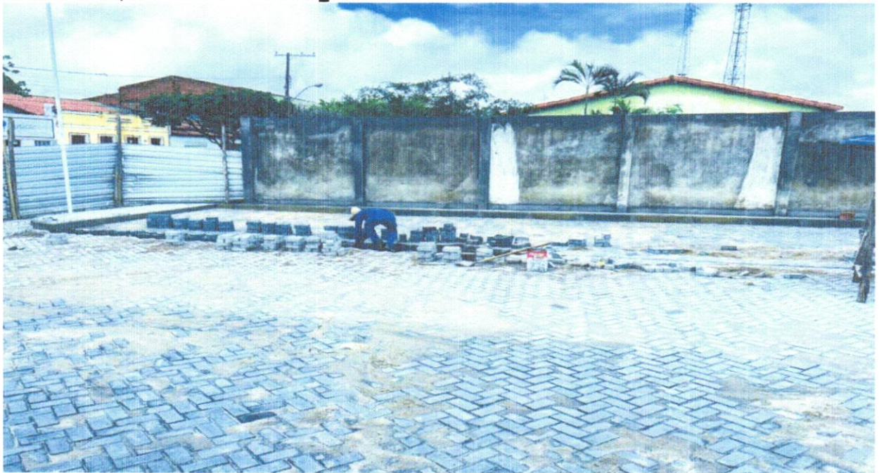
FOTO 41 - EXECUÇÃO DE PÁTIO/ESTACIONAMENTO EM PISO INTERTRAVADO, COM BLOCO RETANGULAR DE 20 X 10 CM, ESPESSURA 10 CM. AF_12/2015
