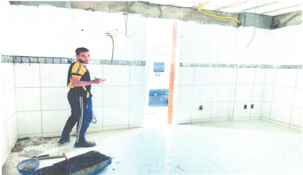
FOTO 04 - Revestimento cerâmico para parede, 10 x 10 cm, Eliane, linha galeria branco mesh, pei - 3, aplicado com argamassa industrializada ac-ii, rejuntado, exclusive regularização de base ou emboço - Rev 01
