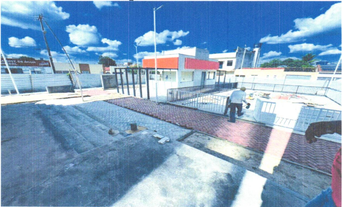
FOTO 45 - EXECUÇÃO DE PÁTIO/ESTACIONAMENTO EM PISO INTERTRAVADO, COM BLOCO RETANGULAR DE 20 X 10 CM, ESPESSURA 10 CM. AF_12/2015
