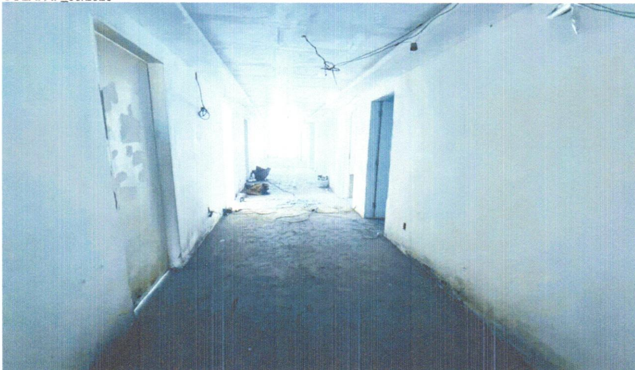
FOTO 05 - PISO VINÍLICO SEMI-FLEXÍVEL EM PLACAS, PADRÃO LISO, ESPESSURA 3,2 MM, FIXADO COM COLA. AF_09/2020
