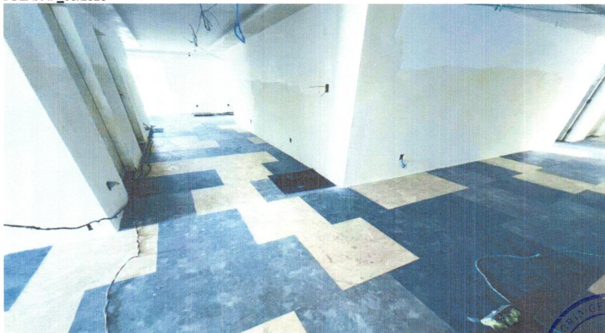
FOTO 12 PISO VINÍLICO SEMI-FLEXÍVEL EM PLACAS, PADRÃO LISO, ESPESSURA 3,2 MM, FIXADO COM COLA. AF_09/2020
