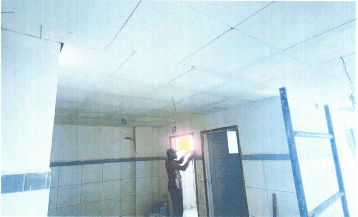
FOTO 22 - FORRO EM PLACAS DE GESSO, PARA AMBIENTES COMERCIAIS. AF_05/2017_P
