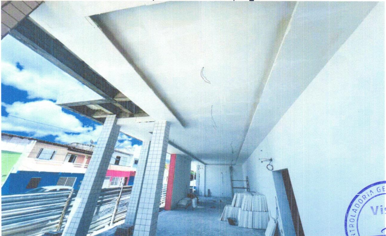
FOTO 16 - ACABAMENTOS PARA FORRO (MOLDURA DE GESSO). AF_05/2017
