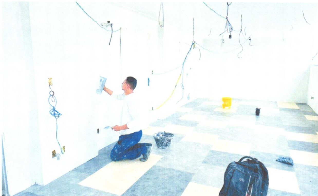
FOTO 24 - EMASSAMENTO COM MASSA A OLEO, DUAS DEMAO S
