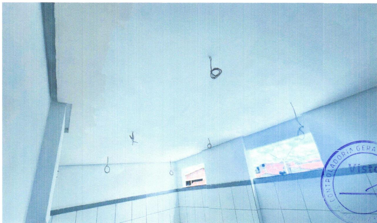
FOTO 24 - EMASSAMENTO COM MASSA A OLEO, DUAS DEMAO S
